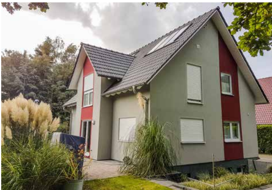
Eine der Kernkompetenzen des Unternehmens: Fassadenanstriche.
