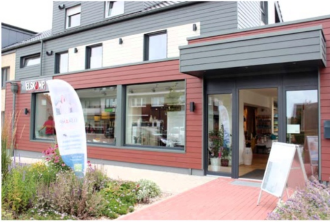
Das Wohn- und Geschäftshaus, in dem sich Elscomp Raumgestaltung befindet, wurde um einen Anbau für den Verkaufsraum und die Werkstatt erweitert.
